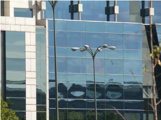
Fig. 4.8. Aspecto de un acristalamiento sometido a los efectos de las presiones "isócoras" en su cámara.
