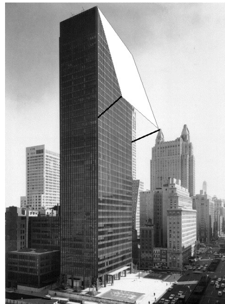
Fig. 3.15. Edificio Seagran con protección solar.
