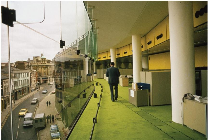
Figura 1.51: Imagen interior de la solución de fachada. Edificio Willis, Faber and Dumas.
