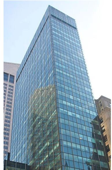
La búsqueda de la desaparición, al menos al exterior, de los inevitables perfiles de la carpintería, da lugar a la aparición de sistemas con el vidrio pegado a la carpintería, dejando una superficie exterior plana, lisa, continua y sin salientes, que aparenta ser solo de vidrio. Para lograr este efecto se utilizan vidrios muy reflectantes, gracias al reciente desarrollo de las capas metálicas. Uno de los primeros ejemplos es el edificio Allied Bank Tower en Dallas, Texas, de I. M. Pei. 1986.
