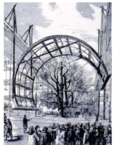
Figura 1.15: Montaje del Crystal Palace.
