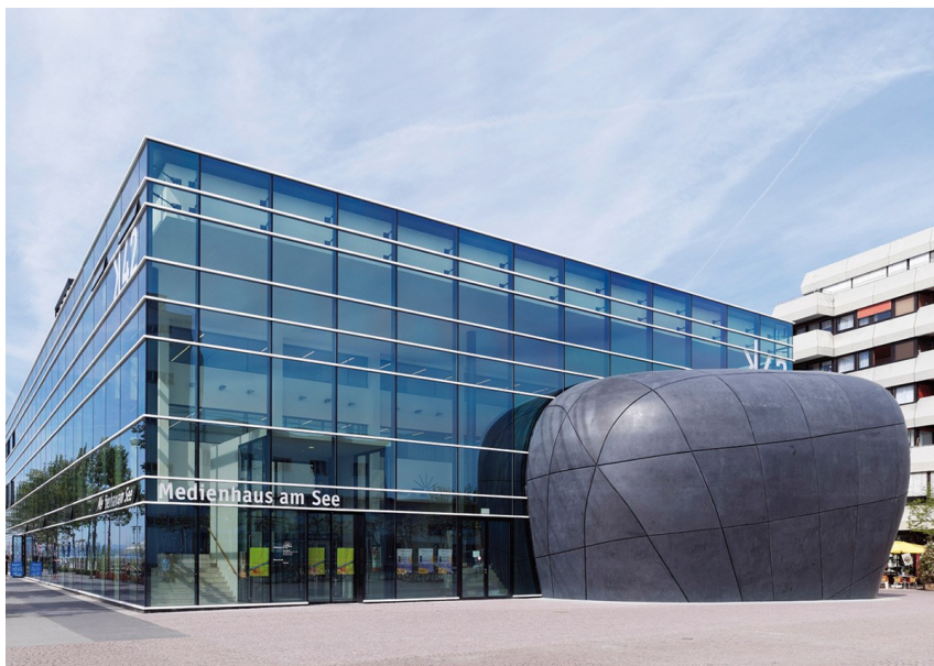
Figura 3.40: Edificio K-42 Medienhaus, en Friedrichshafen, Alemania
