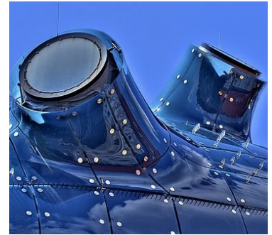
Figura 3.82: Lucernarios del edificio.
