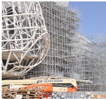
Figura 3.70: derecha: paneles modulares de la envolvente del edificio; sobre estas líneas: estructura metálica soporte de la envolvente.
