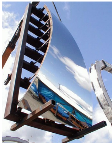
Figura 3.26: Paneles de acero inoxidable de la escultura Cloud Gate de Chicago.
