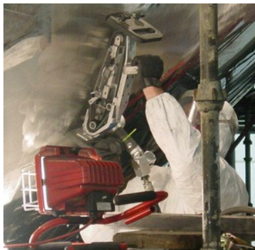
Figura 3.77: Pulido exterior de los paneles para conseguir el efecto espejo.
