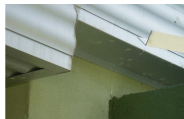
Figura 3.31: arriba: pieza Alustock de extrusión de aluminio; abajo: Detalle de fachada ventilada de planchas de aluminio extruido.
