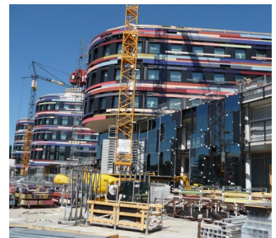
Figura 3.53: Instalación de paneles de fachada.
