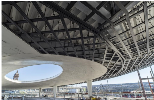
Figura 3.93: Imágenes de construcción del techo de la estación de autobuses.
