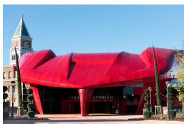
Figura 3.38: Paneles de resinas reforzadas en FerrariLand.
