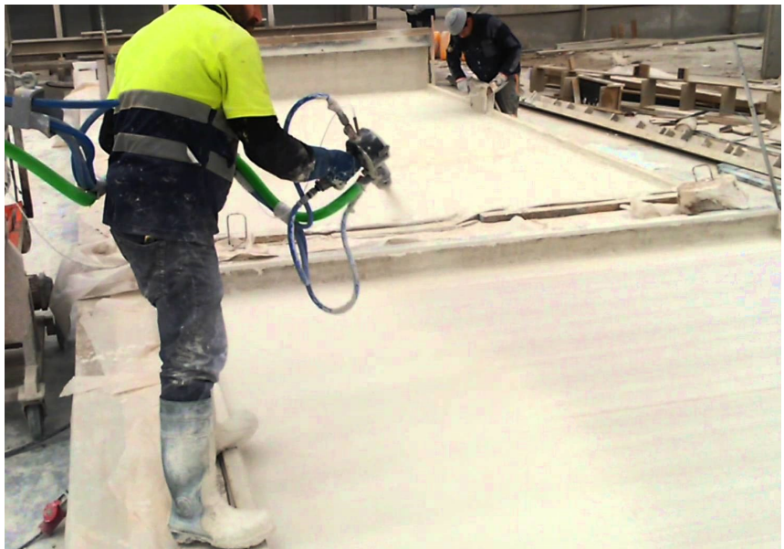
Figura 3.39: Proyección de panel de GRC.
