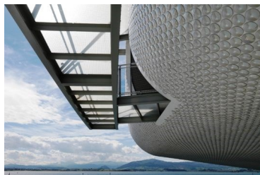
Figura 3.13: Placas cerámicas almohadilladas para fachadas ventiladas. Centro Botín en Santander.
