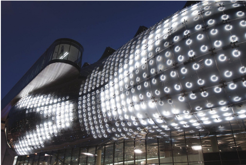
Figura 3.92: Imagen final de noche con las luminarias encendidas.
