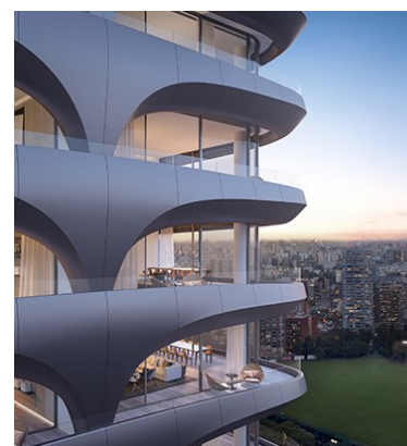
Figura 3.41: Imagen exterior de acabado de fachadas en la nueva torre para Buenos Aires de Zaha Hadid.
