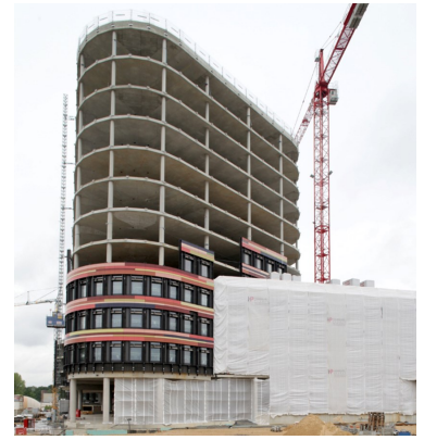
Figura 3.51: Estructura de hormigón y comienzo de instalación de fachada.
