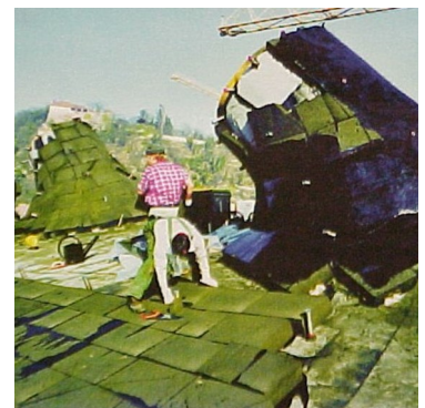
Figura 3.84: Aislante térmico a base de placas de vidrio celular (en la imagen, los volúmenes de color verde), sobre estructura soporte del edificio.
