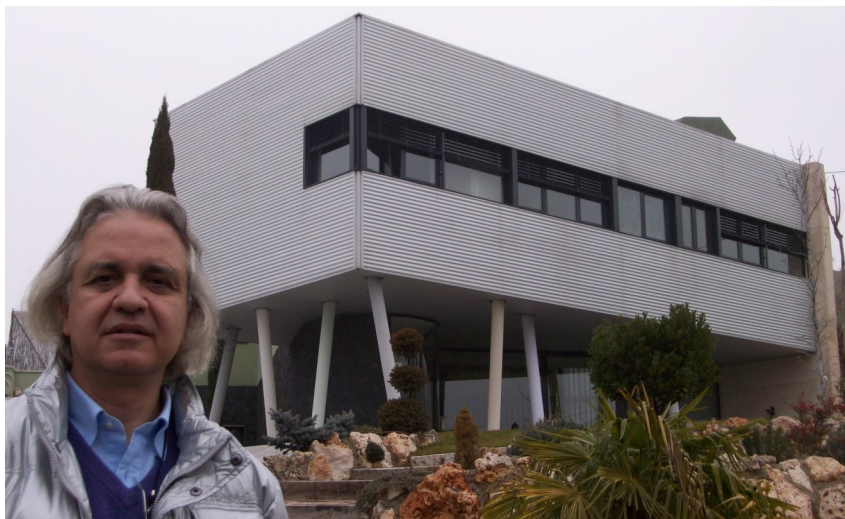
Figura 3.30: Izquierda y derecha: vivienda con fachada ventilada de planchas de aluminio extruido.
