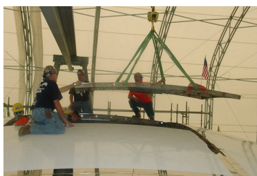
Figura 3.80: Colocación de paneles.
