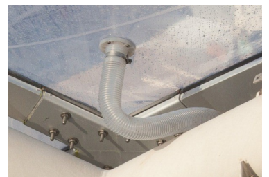
Figura 8.6: Conducto para inflado de cojines de ETFE.
