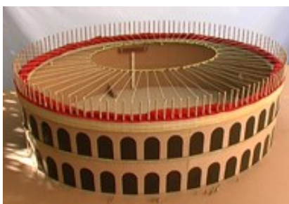
Figura 8.8: Maqueta conceptual de la cubierta retráctil textil del Coliseo.
