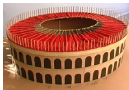
Figura 8.8: Maqueta conceptual de la cubierta retráctil textil del Coliseo.
