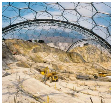
Figura 8.13: Interior del Eden Project durante su construcción.
