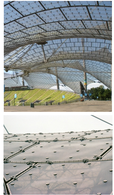
Figura 8.10: Imágenes de la cubierta del estadio olímpico de Múnich.
