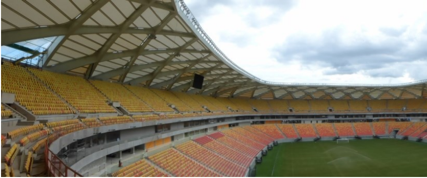
Figura 8.4: Cubierta de fibra de vidrio con PTFE.
