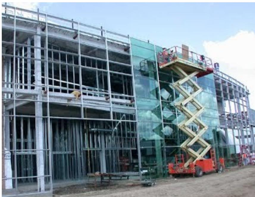
Figura 10.8: Montaje de muro cortina stick con andamio extensible de tijera.
