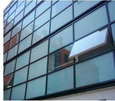
Figura 10.24: Muro cortina stick con tapetas
