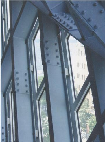
Figura 10.36: Vista desde el interior de la fachada. Nótese la diferenciación entre estructura portante y perfiles estructurales para la fachada.
