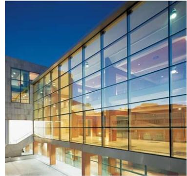
Figura 10.27: Muro cortina stick sin tapetas
