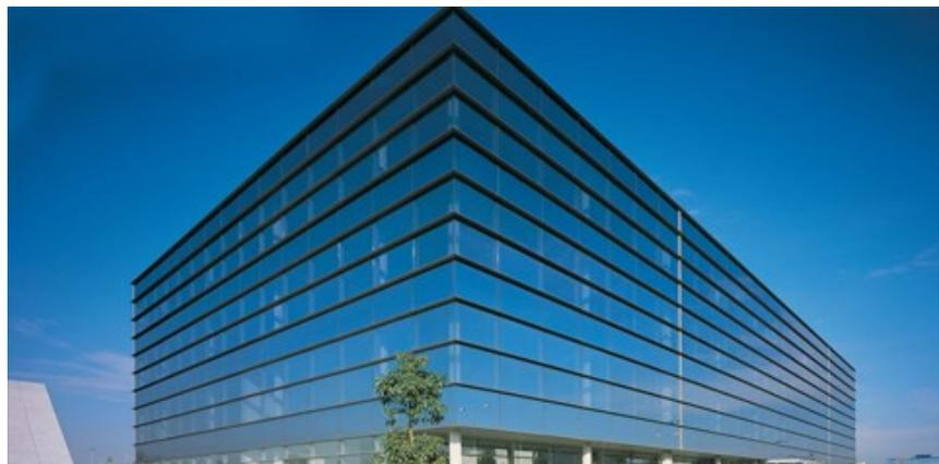
Por su parte, el sistema de muro cortina stick con tapetas verticales deja, al contrario que el caso anterior, las horizontales poco marcadas por el uso de silicona estructural y las verticales claramente definidas por el empleo de tapetas al exterior.
