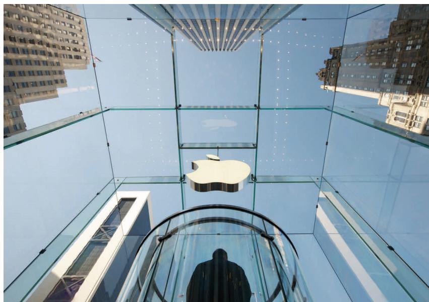
Figura 12.26: Vista de la caja de vidrio de Apple en la Quinta Avenida de Nueva York. Se aprecian los insertos de titanio entre los vidrios de fachada y las costillas interiores.
