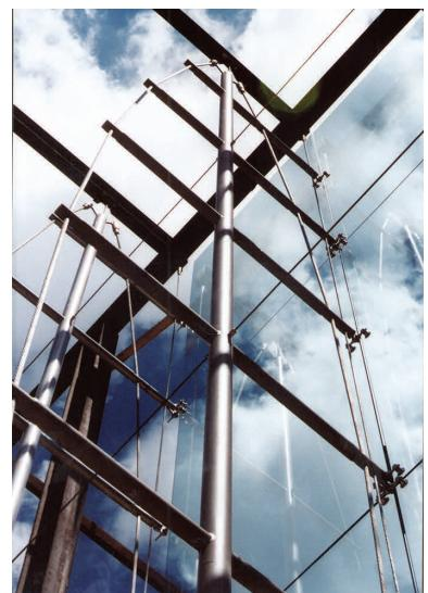
Figura 12.19: Subestructura de mástil atirantado.
