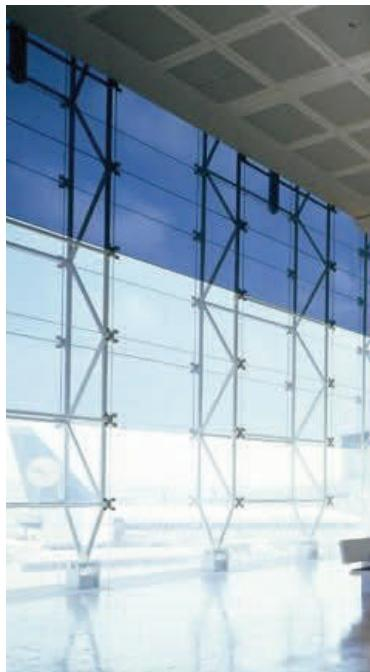
Cuando se descarta la estructura soporte de costillas de vidrio, la alternativa son las estructuras metálicas. Estas estructuras se convierten, por tanto, en un elemento expresivo de primer orden en el proyecto. En consecuencia, el tipo de estructura metálica elegida supone automáticamente una decisión estética crucial. Dentro de las diferentes opciones destacan aquellas que buscan la reducción máxima de sus secciones, en pos de la máxima transparencia.
