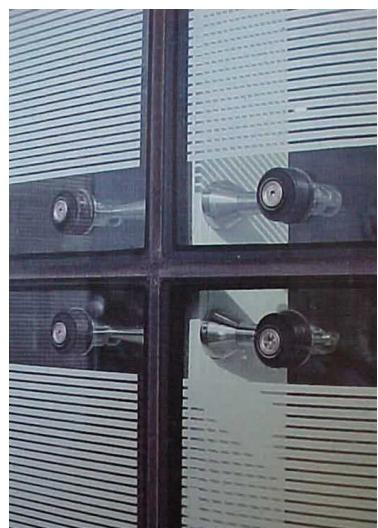
Figura 12.9: Sistema Planar con montantes
