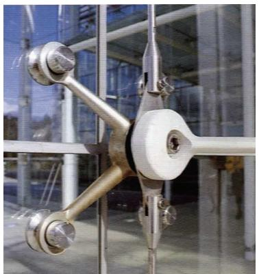
Figura 12.4: Ensamblaje de cuatro puntos para sistema Planar.
