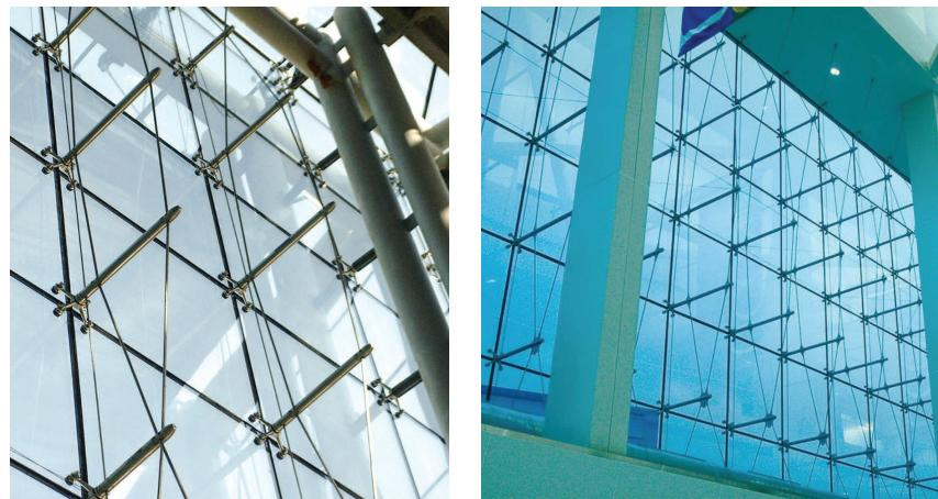
Figura 12.22: Ejemplos de subestructuras de cerchas de cables.
