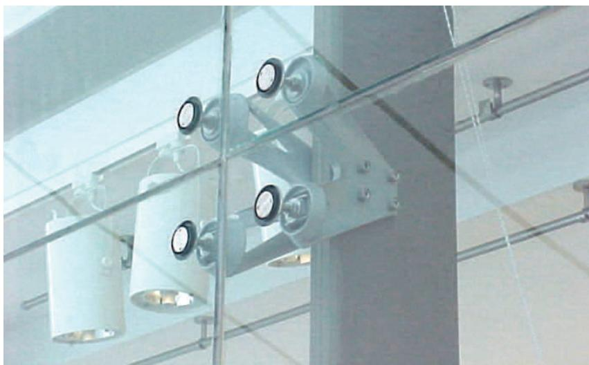
Figura 12.8: Sistema Mecano con montantes
